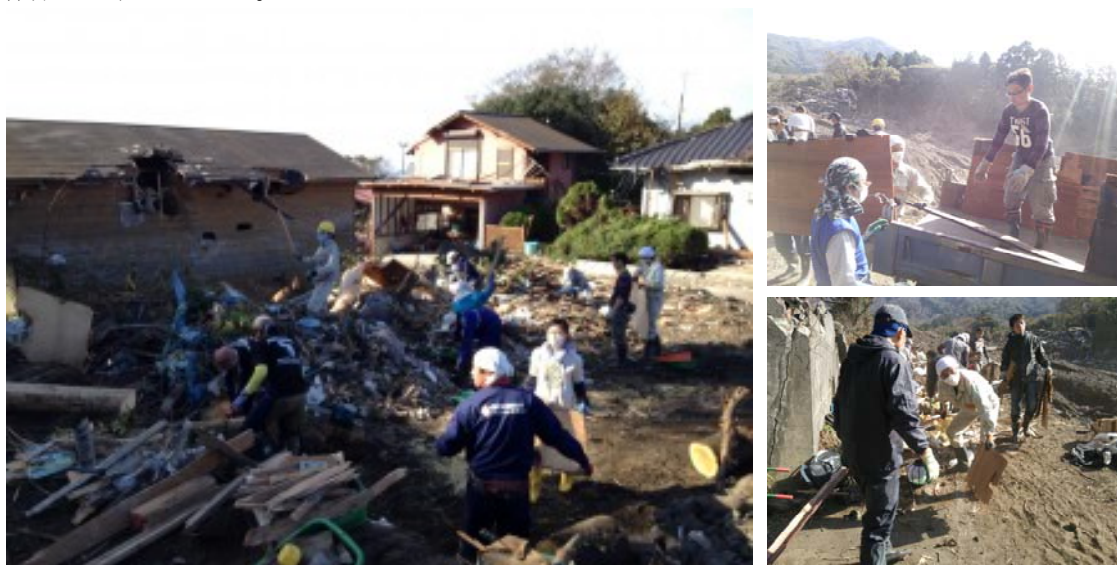
※2 日目の瓦礫撤去作業。(写真左：DSP ホームページより)
