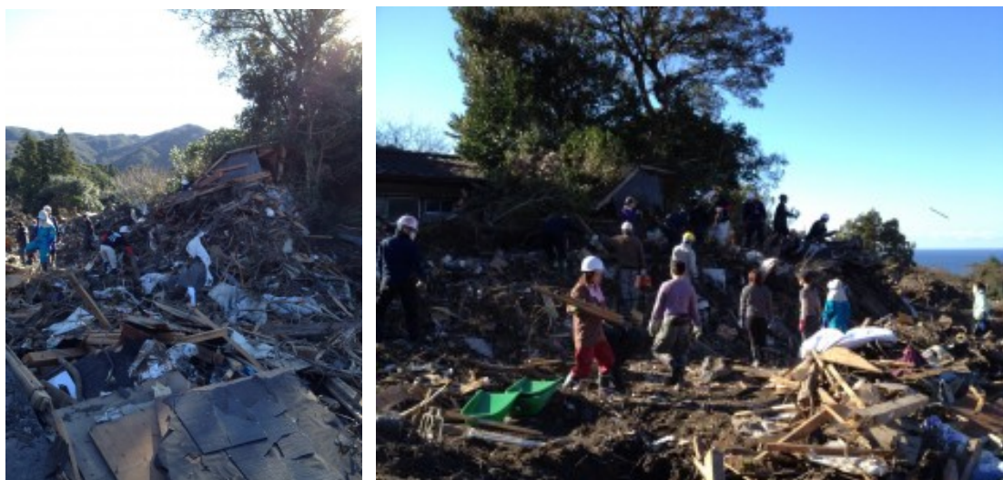
※高く積み上げられた瓦礫を手作業で撤去しました。(写真：DSP ホームページより)
